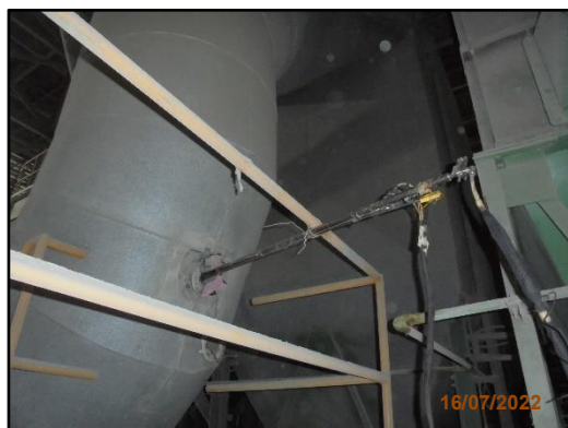
ภาพที่ 3.7 การตรวจวัดคุณภาพอากาศจาก ปล่องหม้ออบซีเมนต์ 7
